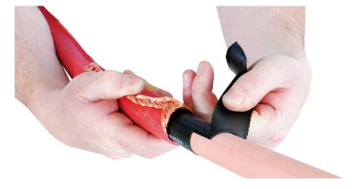
外部半導電層の剥ぎ取り
