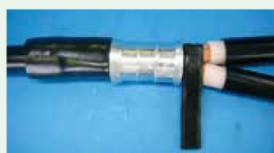
2 防水パテ及び粘着カバーにて コネクタとの径合わせ
