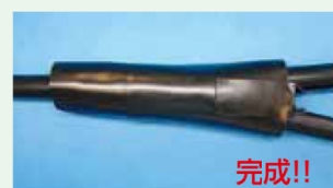
6 分岐線部に粘着カバー巻き
